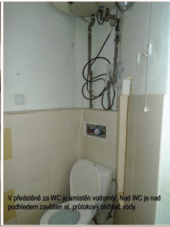
Rohem koupelny, po nedávné rekonstrukci domovních rozvodů, prochází stoupací potrubí vody, které je umístěno v pilířku
